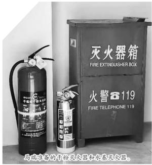
马瑞准备的干粉灭火器和水基灭火器。
